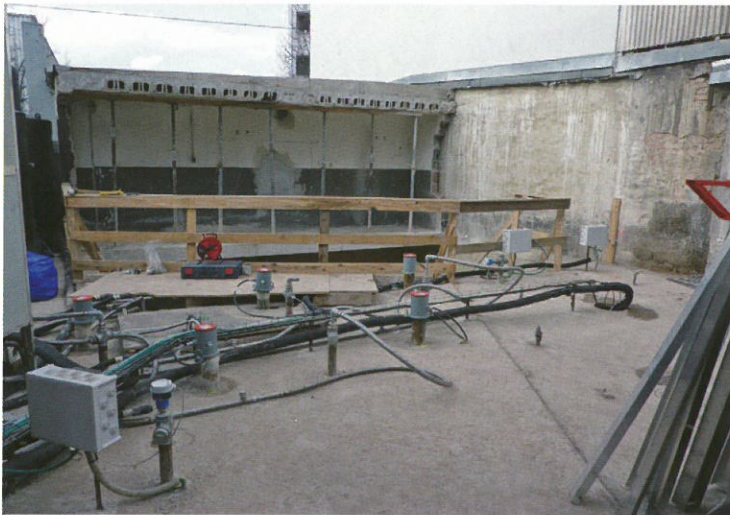
04 Der Heizbereich des Pilotversuchs hatte einen Durchmesser von 4,5 m und eine Tiefenerstreckung von 3,5 bis 10,5 m unter Gelände
